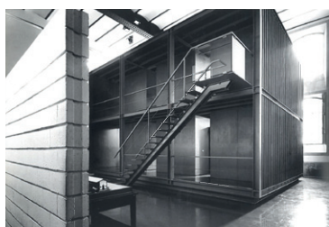
72 Souto de Moura, Reconversão do edifício da Alfândega do Porto em Museu dos Transportes e da Comunicação, Porto, 1993-2002
