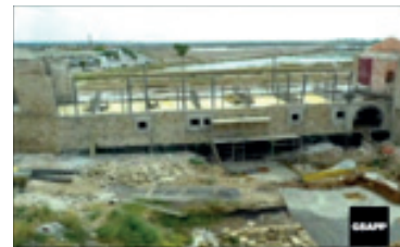
92 Construção da volumetria da ala nascente do pátio central
