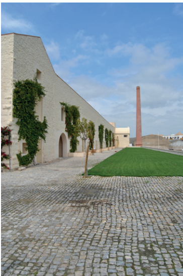
138 Reversão do Convento das Bernardas, zona reconstruída no prolongamento da ala nascente
