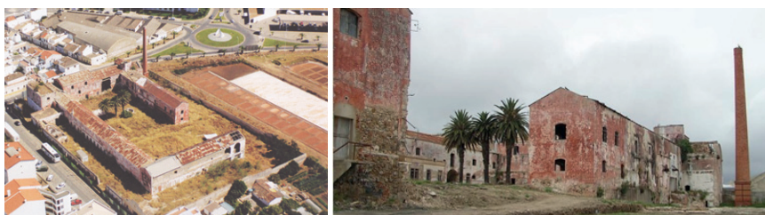
75 Vista aérea da ruína do Convento das Bernardas antes da reabilitação
