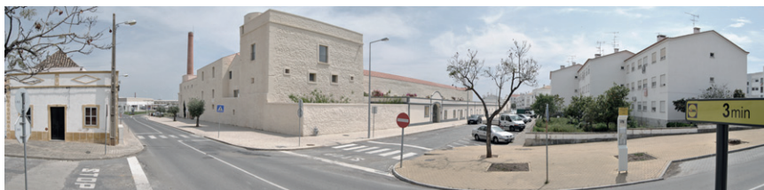
87 Convento das Bernardas, vista do cruzamento entre a Rua dos Mártires e a Rua Atalaia
