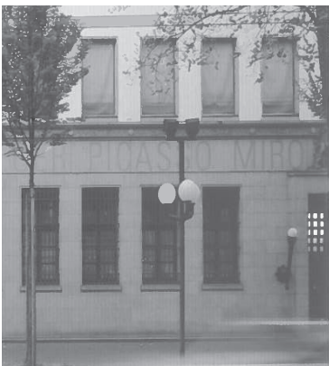
113 Edifício da Coleção Rosengart, Lucerna, 1999-2002
