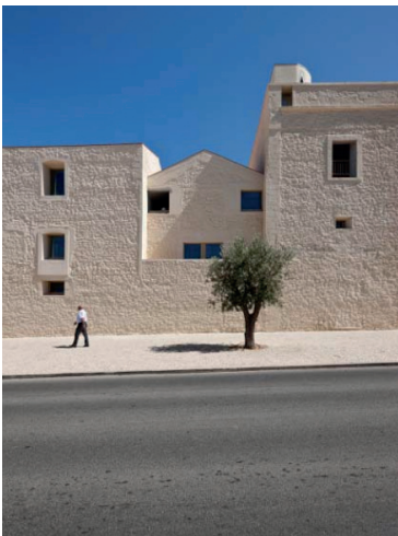
82 Sobreposição volumétrica, fachada norte do Convento das Bernardas
