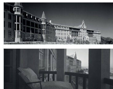
73 Souto de Moura, Conversão do Sanatório dos Ferroviários em Pousada, Covilhã, 2011
