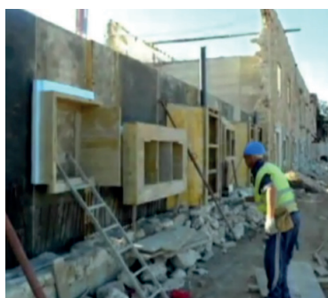
85 Fase de construção e reforço estrutural dos vãos
