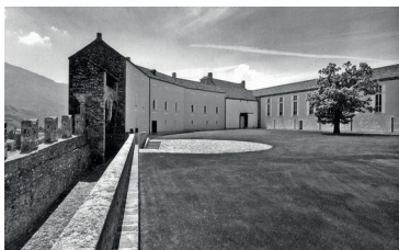
43 Aurelio Galfetti, Restauro do Castelgrande, Bellinzona, Suíça, (1ª parte) 1981-1991, (2ª parte) 1992-2000
